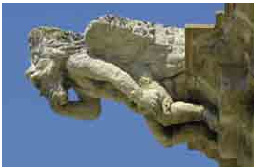
Una de las gárgolas de la fachada principal.
