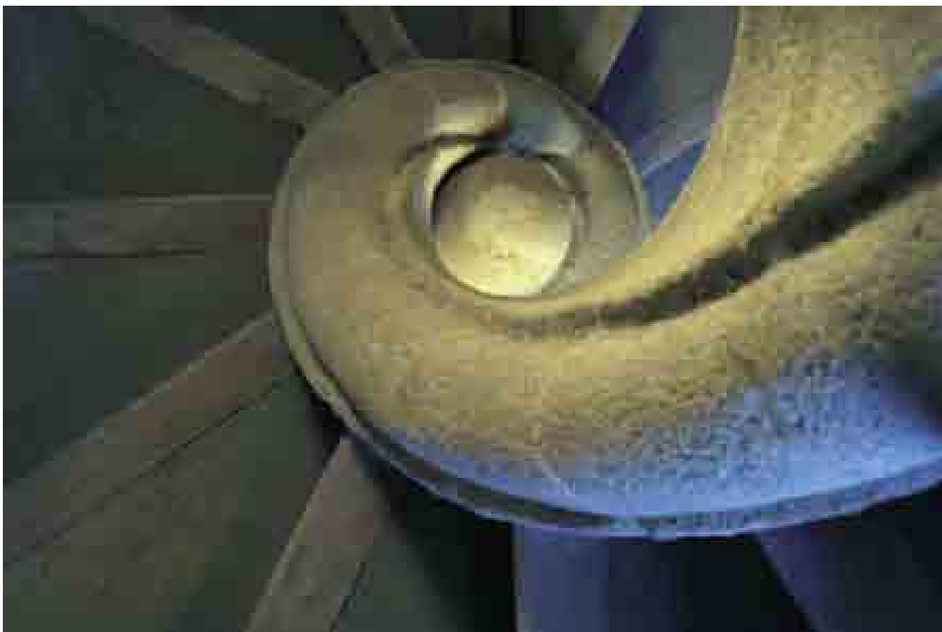
Caracol de Mallorca que sube a las galerías laterales.
