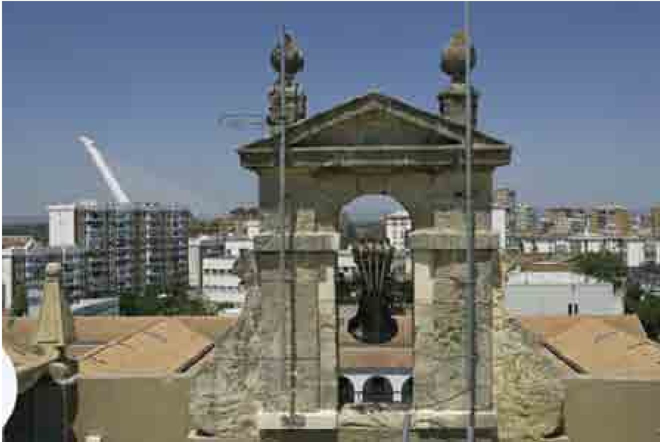
Espadaña ubicada en la cubierta de la antigua iglesia.
