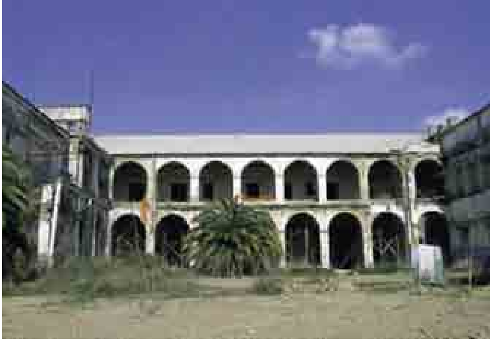
El patio central de la zona norte del edificio antes de las obras comenzadas en 1999.
