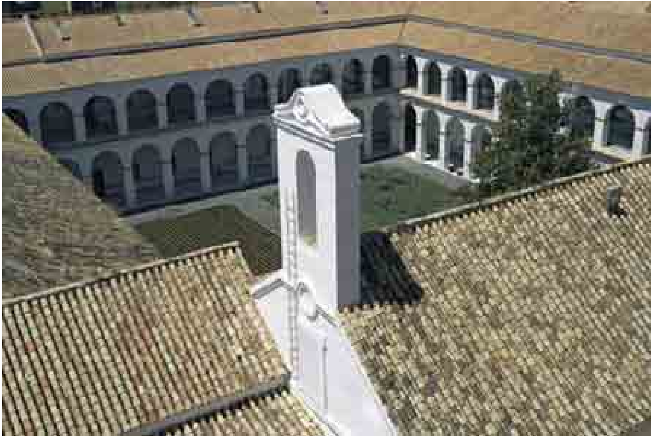
La espadaña de la cabecera del crucero de poniente.
