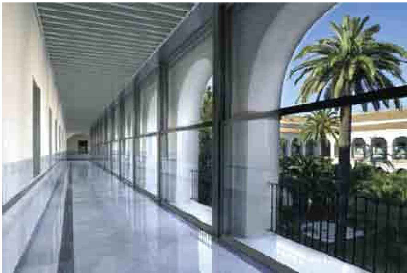
El patio del Cardenal tras las obras comenzadas en 1999.
