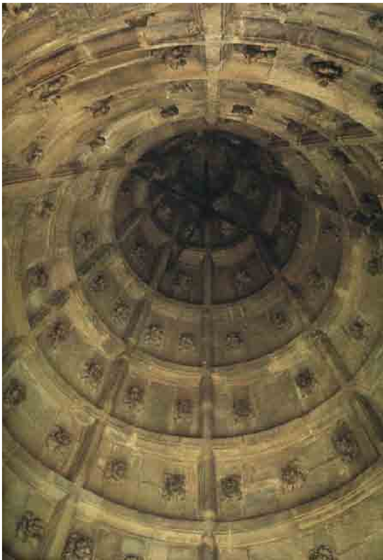
Intradós de la cubierta de la torre sudoeste.
