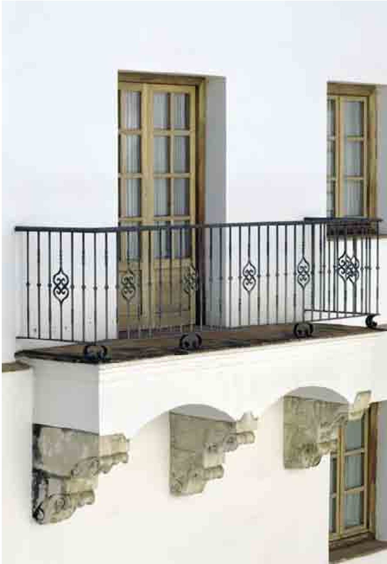
Balcón sobre ménsulas del patio de la Botica.
