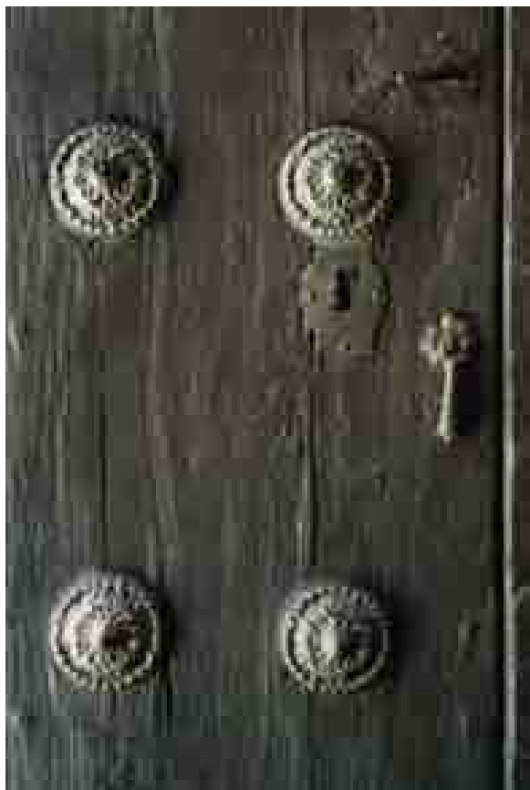
Detalle de la carpintería, clavazón y herrajes de la puerta principal del salón de Plenos
