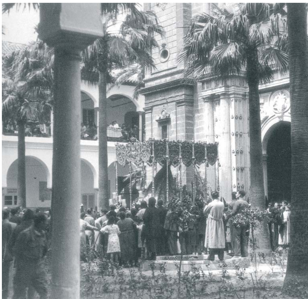
El paso de la Macarena ante la iglesia del hospital. Viernes Santo de 1937.
