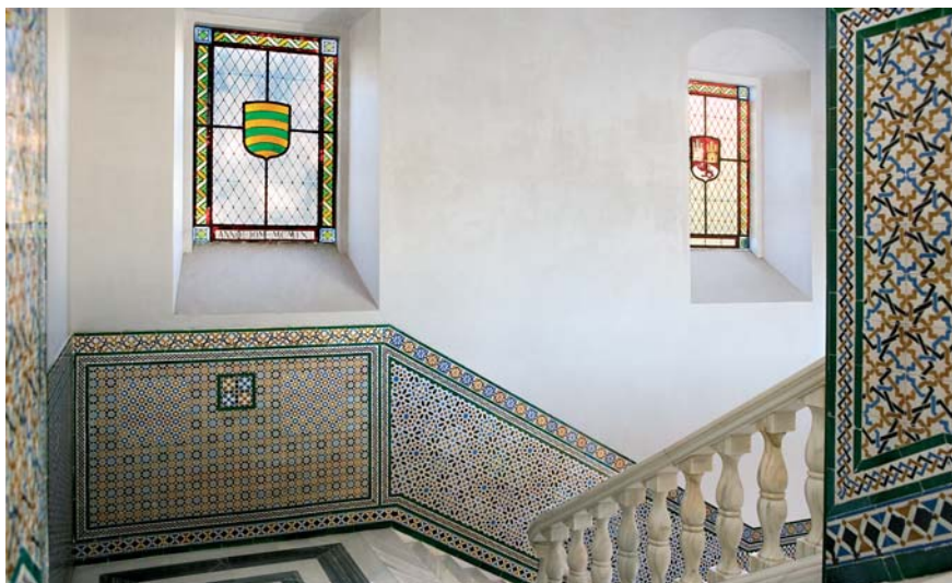
Escalera del patio del Cardenal después de la restauración.
