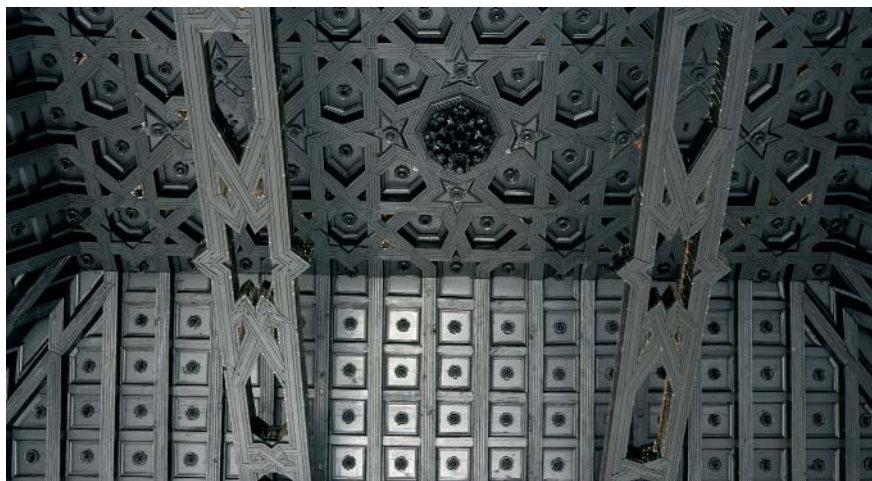
Armadura de par y nudillo. No consta su fecha.
