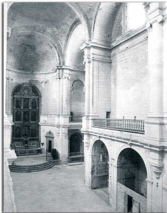
Interior de la iglesia en la fase de restauración.
