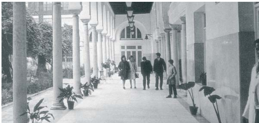
Galería del patio del Recibimiento en la última etapa del hospital Central.
