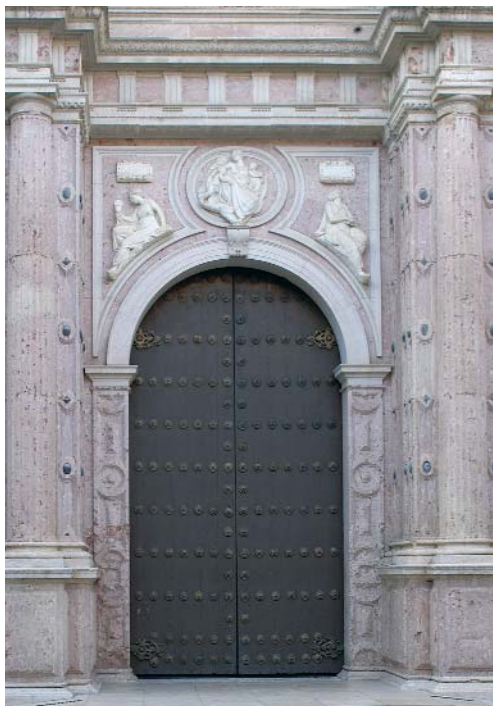
Pórtico de la fachada principal de la iglesia.
