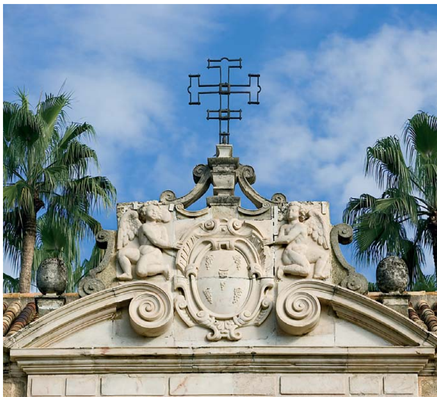
Pórtico de la fachada principal.
