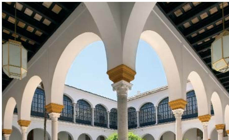
Intersección de dos galerías del patio del Alcohol.
