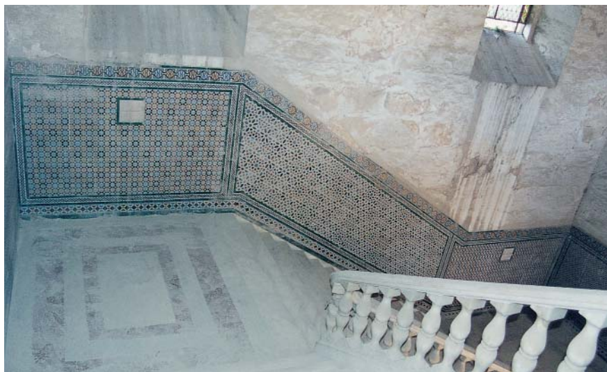
Escalera del patio del Cardenal antes de la restauración.
