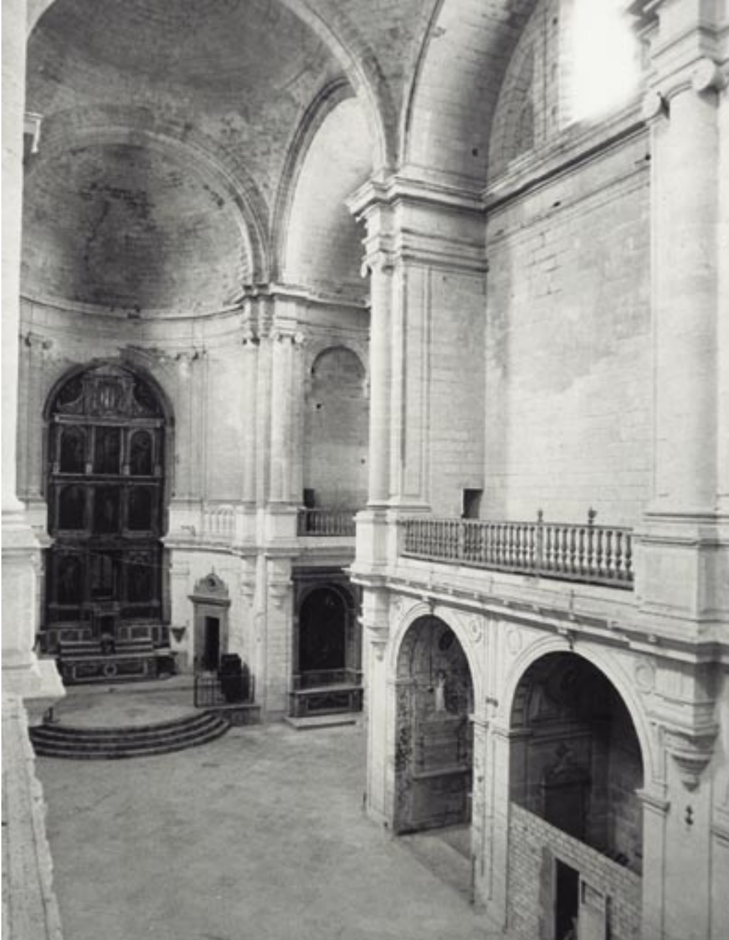
IGLESIA DEL HOSPITAL DE LAS CINCO LLAGAS DURANTE SU RESTAURACIÓN
