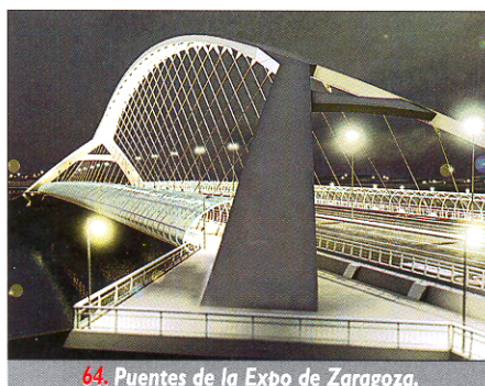
64. Puentes de la Expo de Zaragoza.
