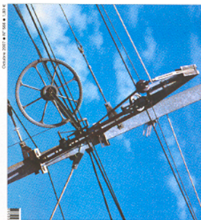
Los túneles de Guadarrama, en pruebas ● Autovía Mudéjar: de Levante al Pirineo ● Ampliación del aeropuerto de Málaga ● Geodesia para una cartografía más precisa
