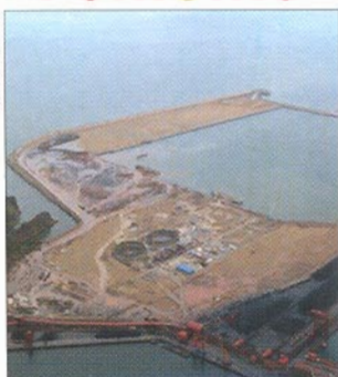
Ampliación del puerto de Gijón
