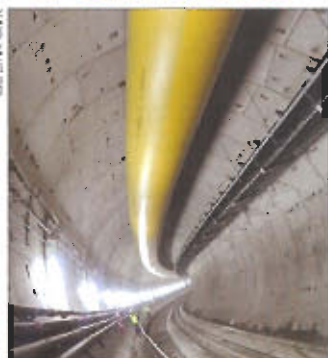
Túnel Chamartín-Atocha, la gran vía del AVE
