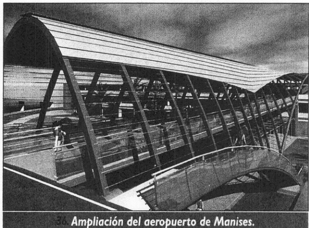
36 Ampliación del aeropuerto de Manises.
