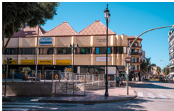
Apeadero de autobuses de Fuengirola, ubicado en la calle Alfonso XIII, prolongación de la avenida Clemente Díaz Ruiz, principal acceso de los autobuses interurbanos.
